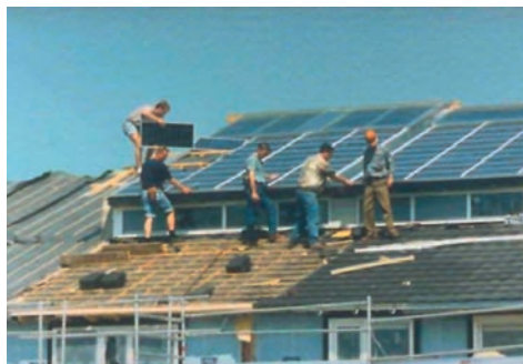
Figura A.12 Montaggio di un sistema fotovoltaico installato su copertura 9
