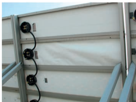
Evidente distacco del tedlar
