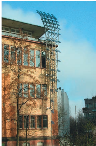
Figura A.14 Die Hochschule für Bildende Kunst (Germania), una interessante applicazione retrofit
