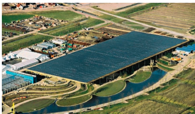
Figura A.4 Copertura fotovoltaica (2,3 MW p ) realizzata ad Haarlemmermeer in occasione della Floriade Exhibition 2002
