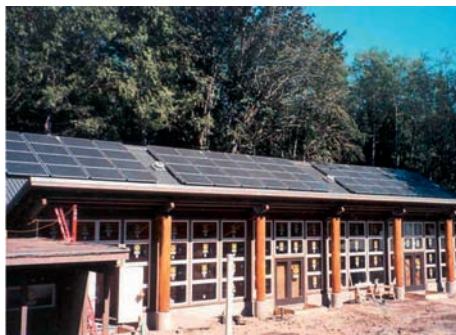
Environmental Learning Center, Puget Sound (WA), copertura con pannelli fotovoltaici
