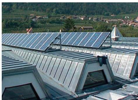
Esempio di impianto non integrato Istituto Frankenberg (BZ), impianto FV da 3,1 kW
