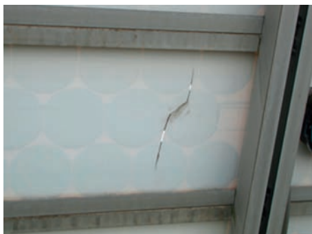
Fessurazione del tedlar
