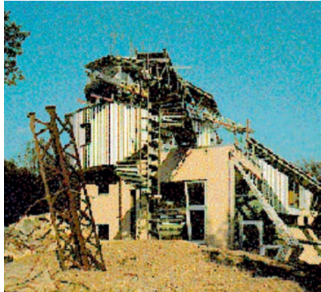
Figura A.13 Casa unifamiliare solare realizzata in una ex cava di ghiaia a Kieswerk (Svizzera) a) stato del luogo e dell'edificio precedente l'intervento b) realizzazione
